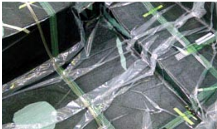
Slika 8.: Primjena pokrivača prilikom izvođenja infuzijskog vakuumnog postupka
