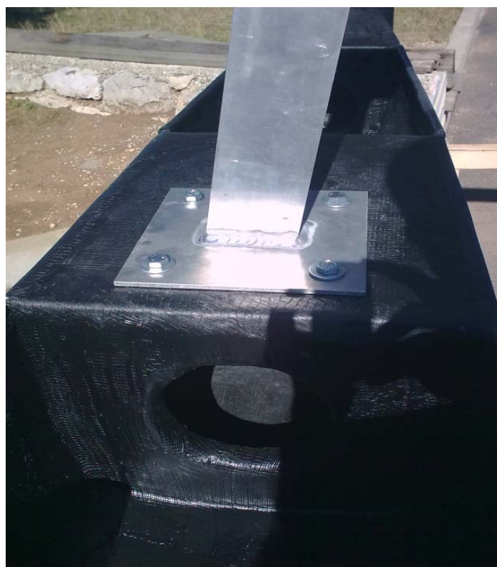
Slika br.7. Aluminijska konstrukcija postavljena na nosač
