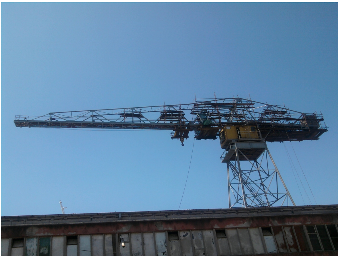
Slika 3.1: Obalna portalna dizalica LP-brodogradilišta za vrijeme popravka
