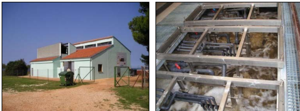
Slika 2. Park Umag, MBR 5000 ES, izgrađeno 2005.
