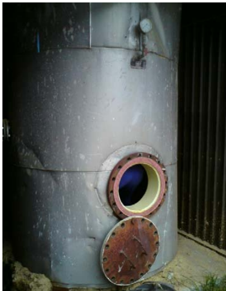
Slika 7. Tlačni spremnik za vrijeme čišćenja i provjere
