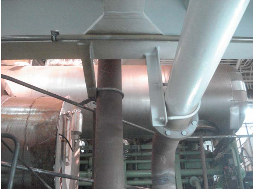
Slika 2.: Poluproizvodi (obujmica i L profil) spremni za montažu na brod.
