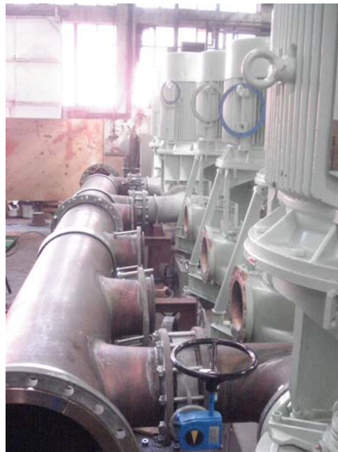
Slika 16.: sastavljanje cijelog modula u radionici brodogradilišta.
