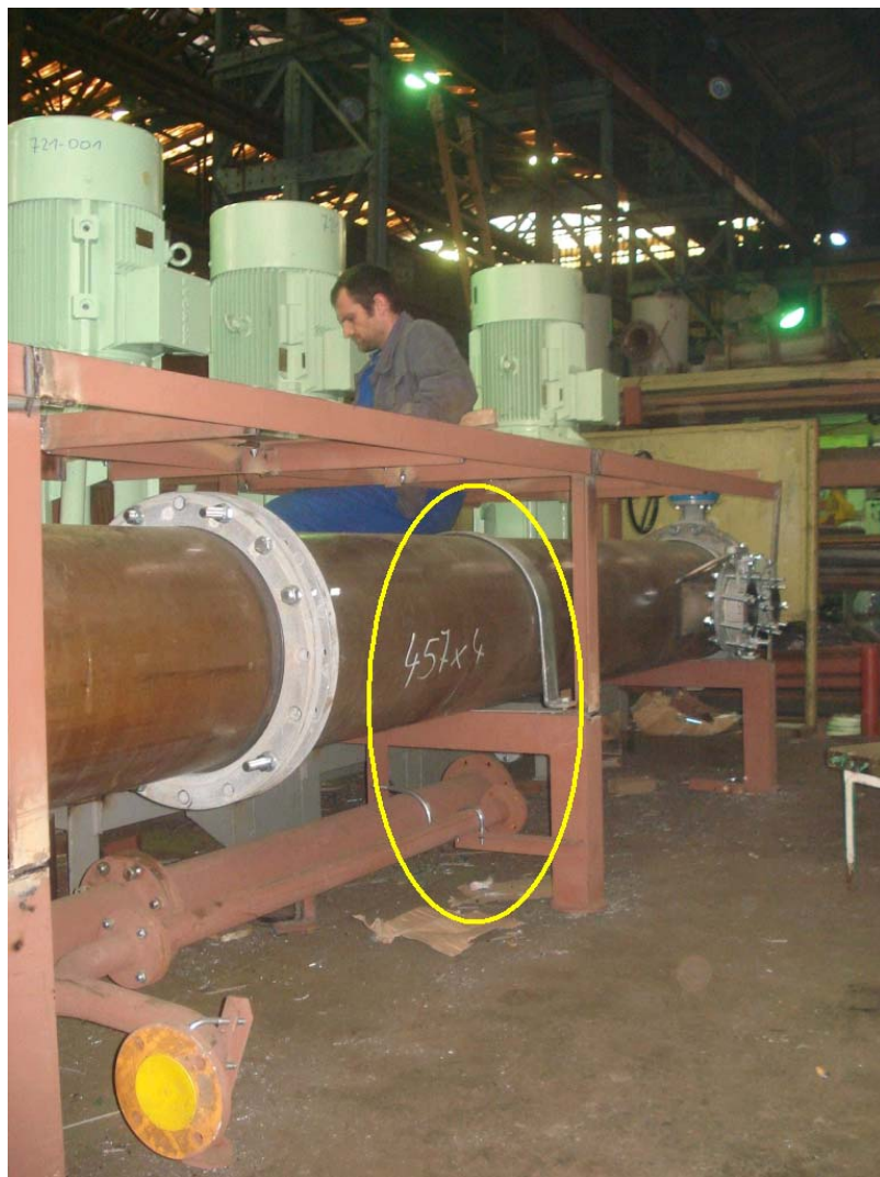
Slika 17.: Kompletno sastavljen modul pumpne stanice sa okvirom podnice spreman za montažu na brod. (Radna skica nosača cijevi zaokruženog na slici priložena je na slijedećoj stranici)
