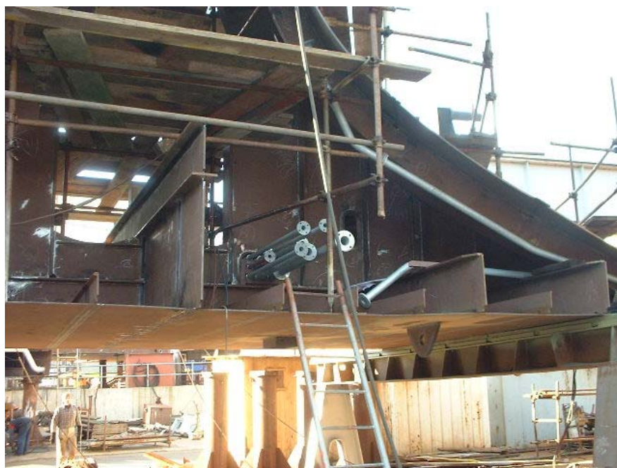
Slika 13.: sekcija opremljena u predmontaži spremna za montažu na navozu
