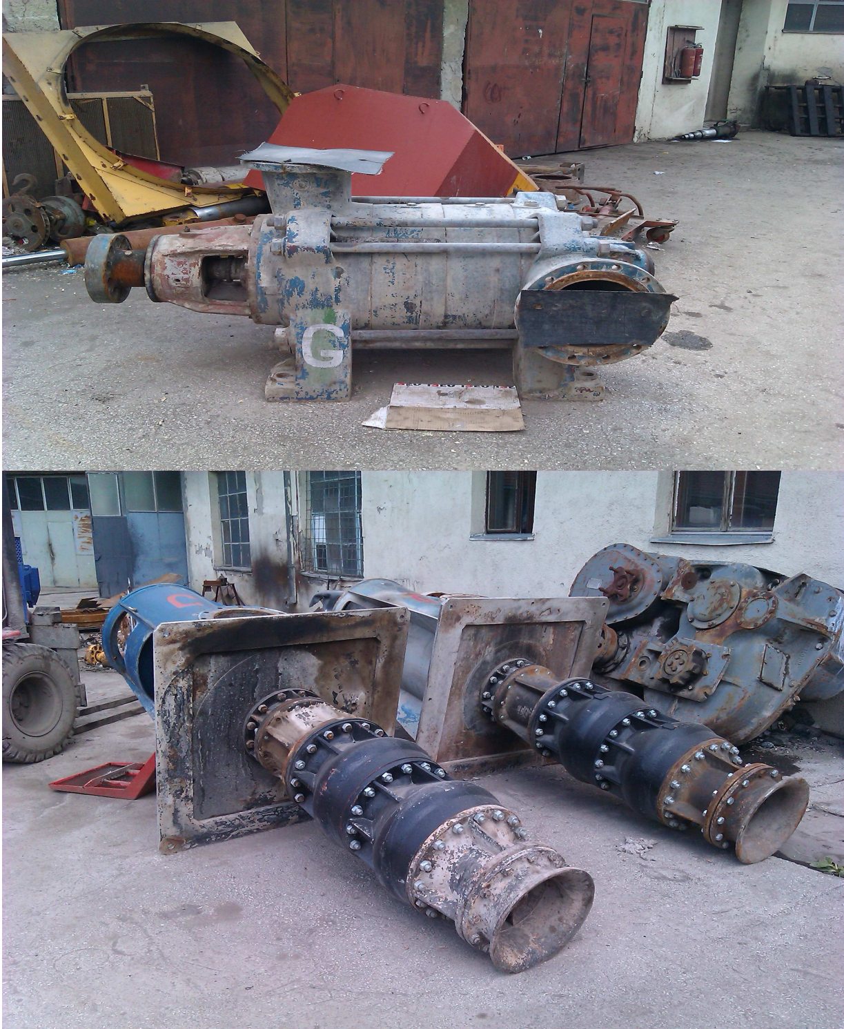
Slika 17 .Remont Vodenih Pumpi
