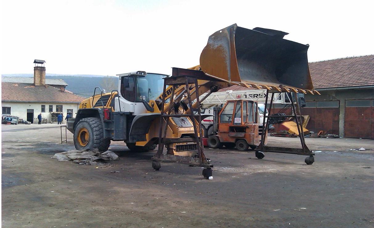
Slika 19. Remont Dampera Perlini i Utovarne Liebherr
