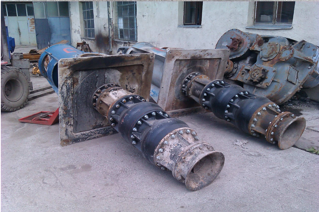
Slika 17 .Remont Vodenih Pumpi
