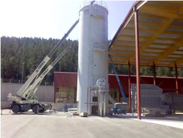
Sl. 41. Montaža silosa
