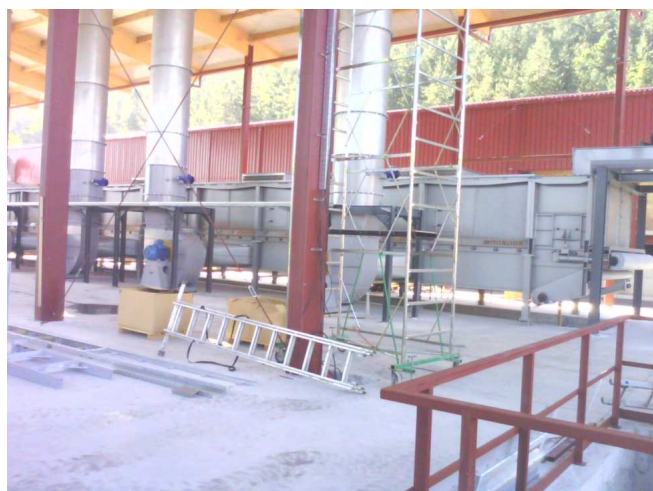
Sl. 40. Montaža sušare za pogon peletare
