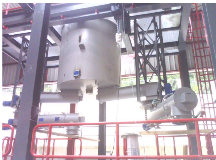
Sl. 19. Montaža silosa sa uređajima za doziranje dvije prese za proizvodnju peleta
