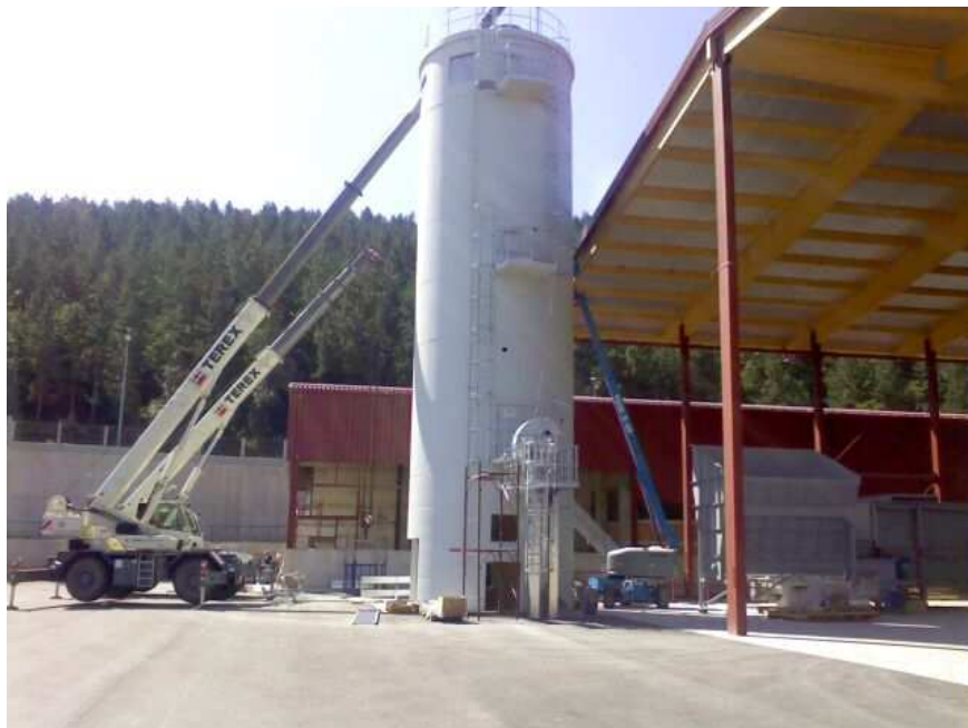
Sl. 12. Silos suvog iverja
