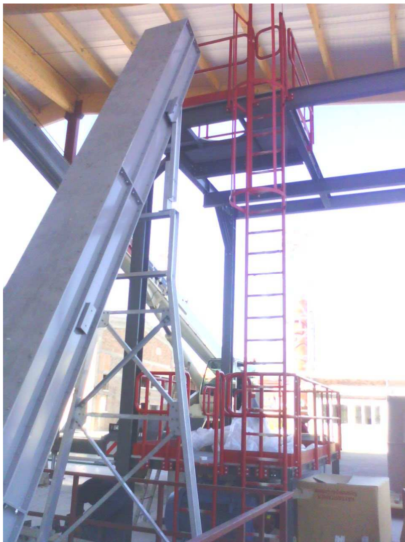
Sl. 5. Montaža postolja za mlin
