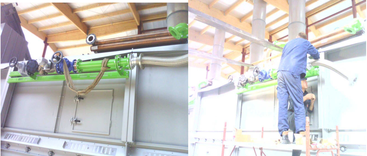
Sl. 7. Montaža uređaja za automatsku kontrolu i regulisanje temperature
