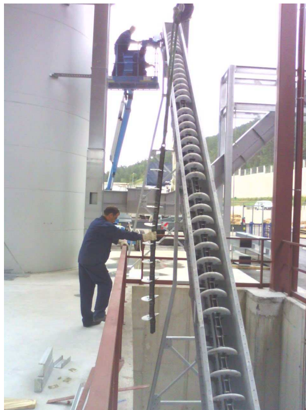
Sl. 50. Montiran lančani transporter od sušare do elevatora sa lopaticama
