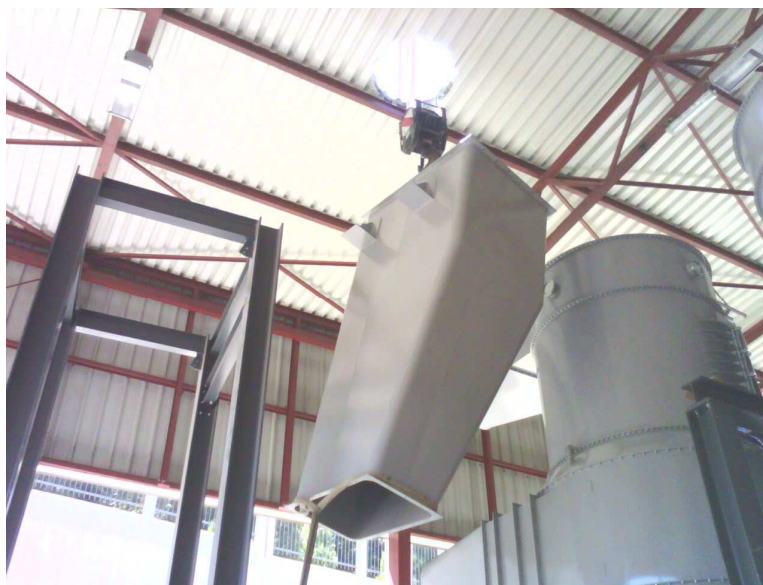
Sl. 14. Montaža pred silosa i mlina za suvo iverje
