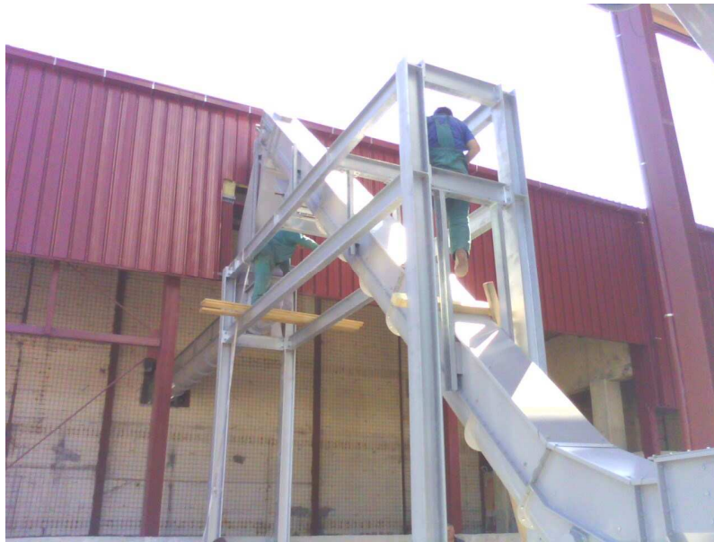
Sl. 51. Montiran lančani transporter od silosa suvog iverja do mlina za suvo iverja
