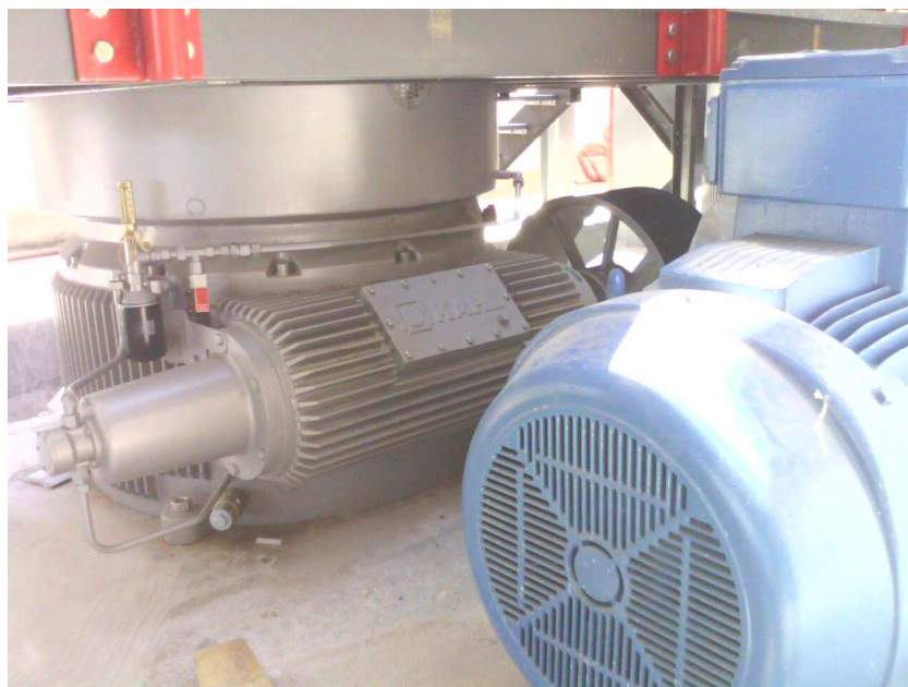
Sl. 20. Montaža motora za prese za proizvodnju peleta
