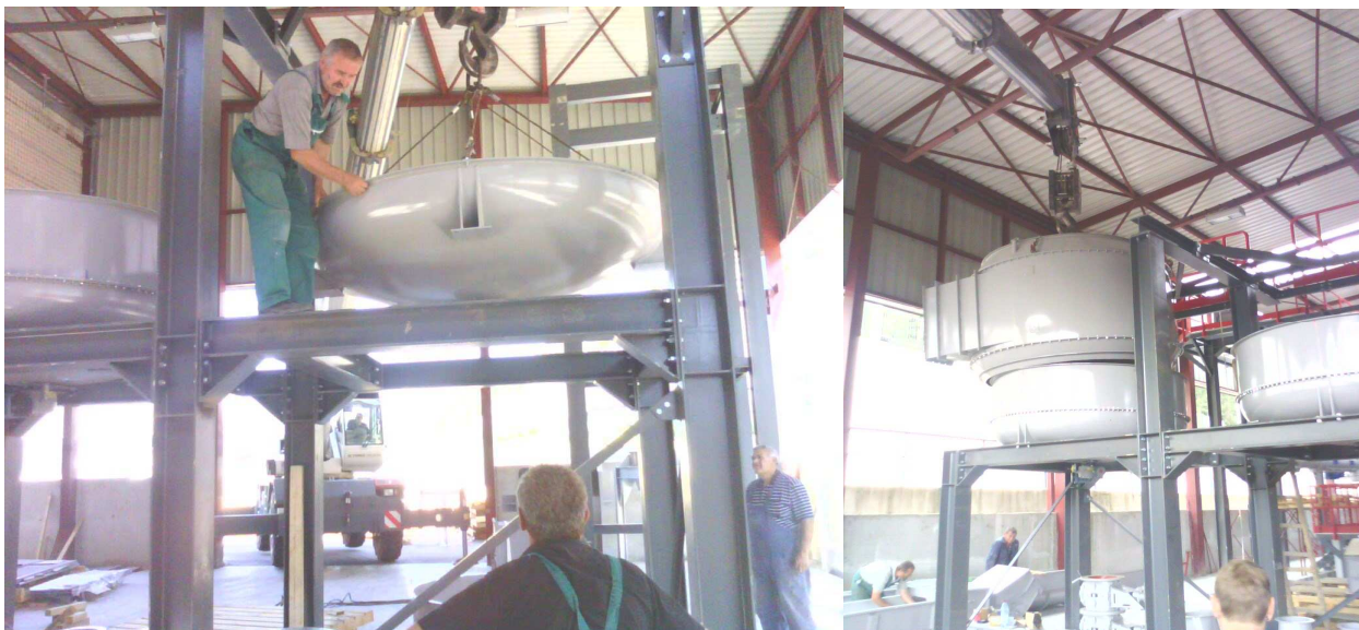
Sl. 16. Montaža uređaja za miješanje i navlaživanje suvog iverja
