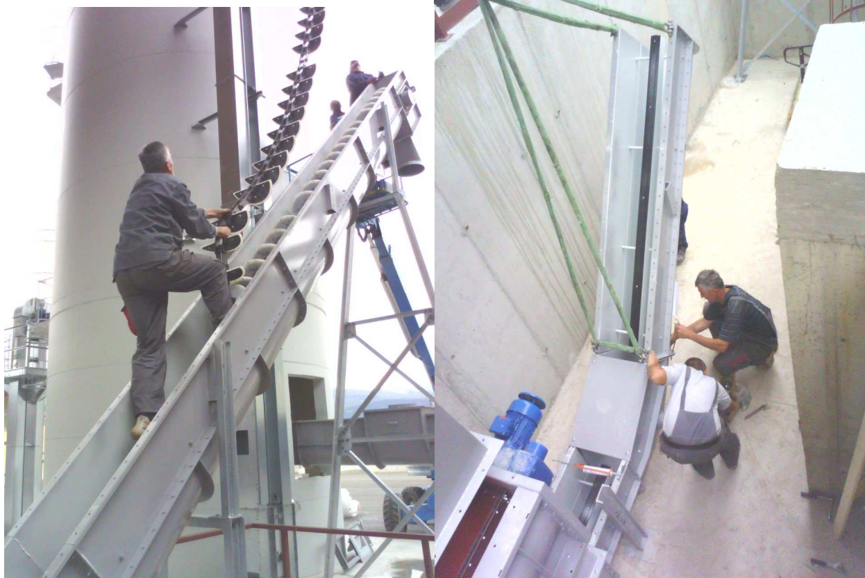
Sl. 10. Montaža lančanog transportera za transport suvog iverja
