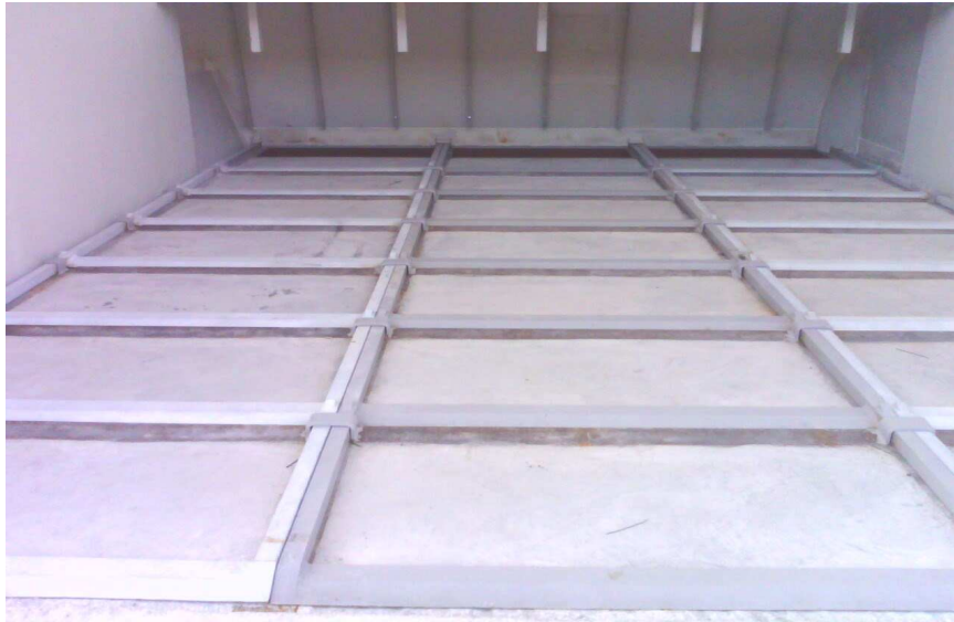
Sl. 3. Pokretna podna površina bunkera
