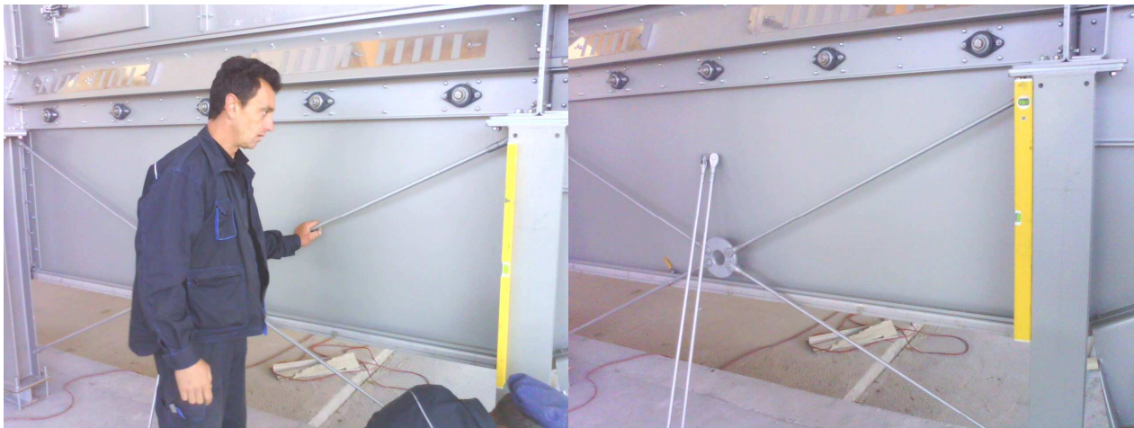
Sl. 9. Montaža elemenata stabilnosti sušare
