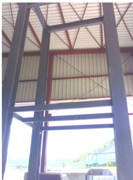
Sl. 13. Montaža nosača mlina suvog iverja i pred silosa
