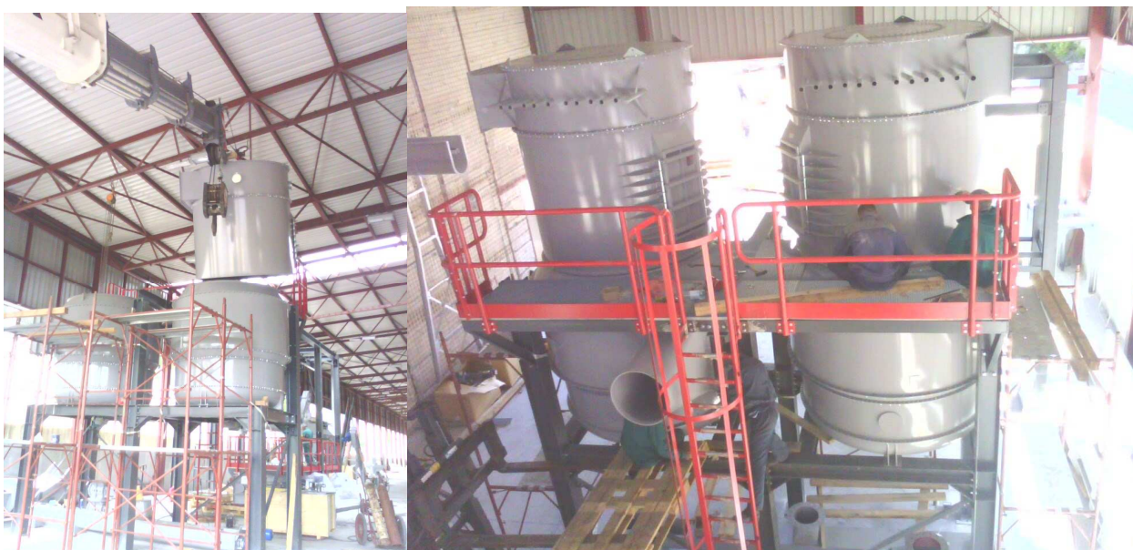
Sl. 17. Završna faza montaže uređaja za miješanje i navlaživanje suvog iverja
