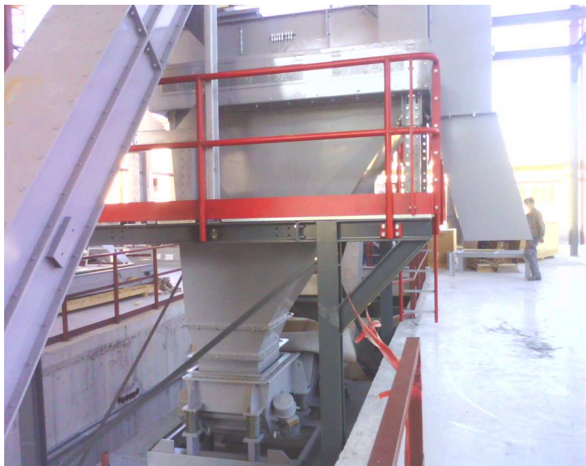
Sl. 4. Montaža sita sa magnetnim odvajачem i separatorom čestica Program studentske prakse
