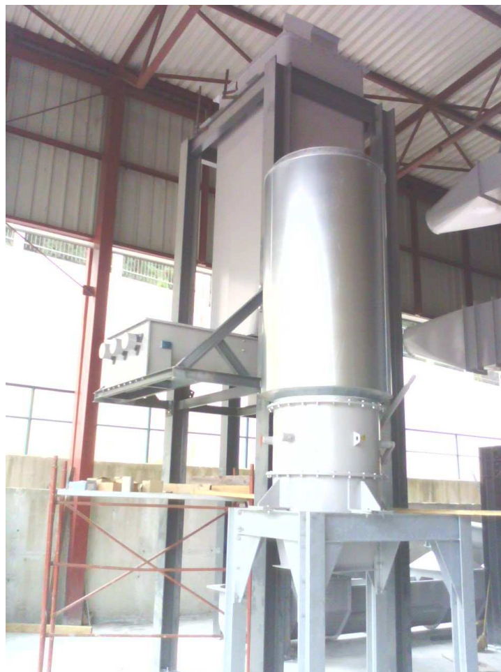
Sl. 52. Montiran pred silos i mlin za suvo iverja
