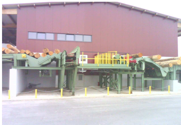
Sl. 33. Dozirna rampa za quadro liniju i liniju tračne pile
