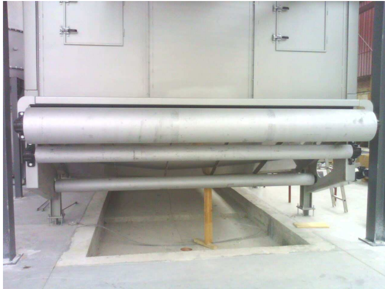
Sl. 8. Montaža valjaka za trakasti transporter
